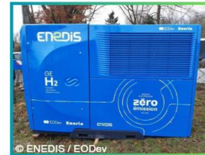
Groupe électrogène H2
