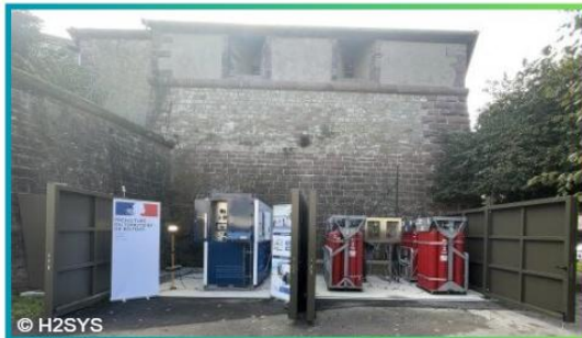
Groupes électrogènes à hydrogène de la Préfecture de Belfort
