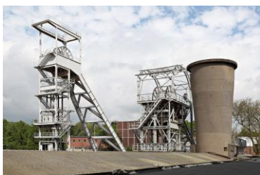
Chevalement d'un puits de mine
